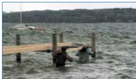
Bau der neuen Steganlage Nach rund 10 Jahren war es wieder so weit: der Steg musste erneuert werden. SCIA-Stegwart Wolfgang Häder (oben Mitte) leitete die Arbeiten bei frischem Wind und „rauer See“.
